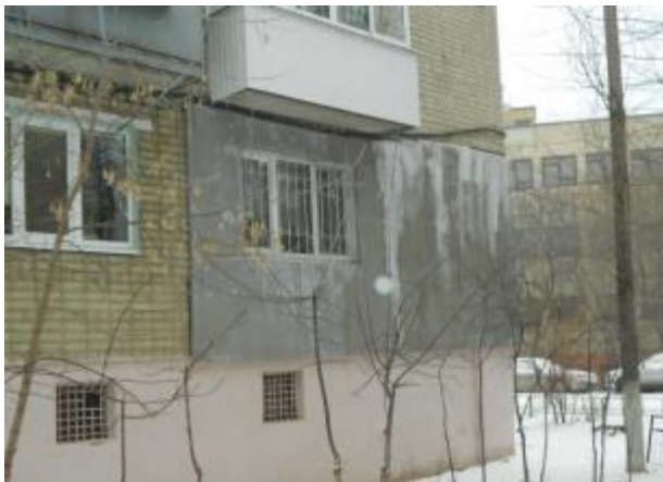
Рис. 1. Наличие влаги в теплоизоляционном слое фасада многоквартирного дома
