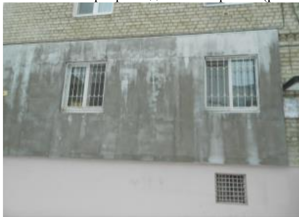
Рис. 1. Наличие влаги в теплоизоляционном слое фасада многоквартирного дома
